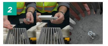
3. UNSCREW THE TWO ALUMINUM PHILIPS HEAD SCREWS ON THE 1" BY 1" CLIP OF THE UNIVERSAL BRACKET. ATTACH THE SMARTDRAIN TO THE BRACKET AND TIGHTEN THE SCREWS.
